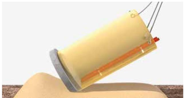
Abb. 2.10 | Aufrichten eines Schachtes mit Seilgehänge
